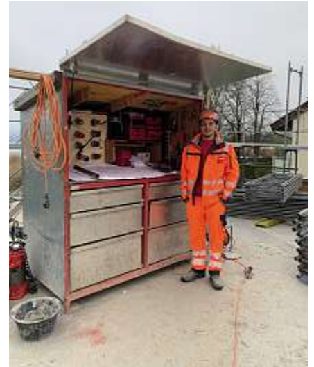
Maurerlehrling Sven Gfeller auf der Baustelle ...
