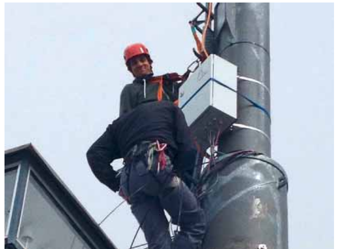
Radio-BeO-Techniker Patric Perret unterstützt die Montage des Anschlusskastens.
