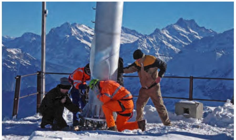
Der Mast wird gesetzt und verankert
