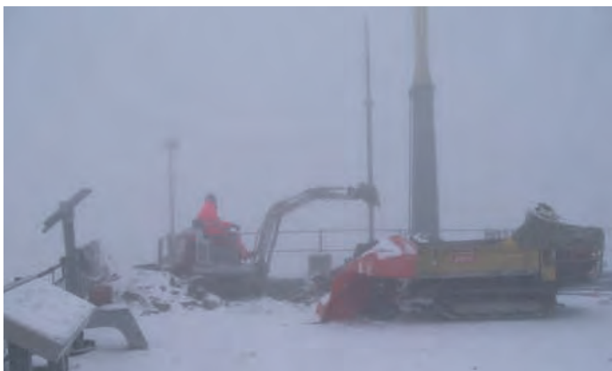
Fundamentbau unter erschwerten Bedingungen
