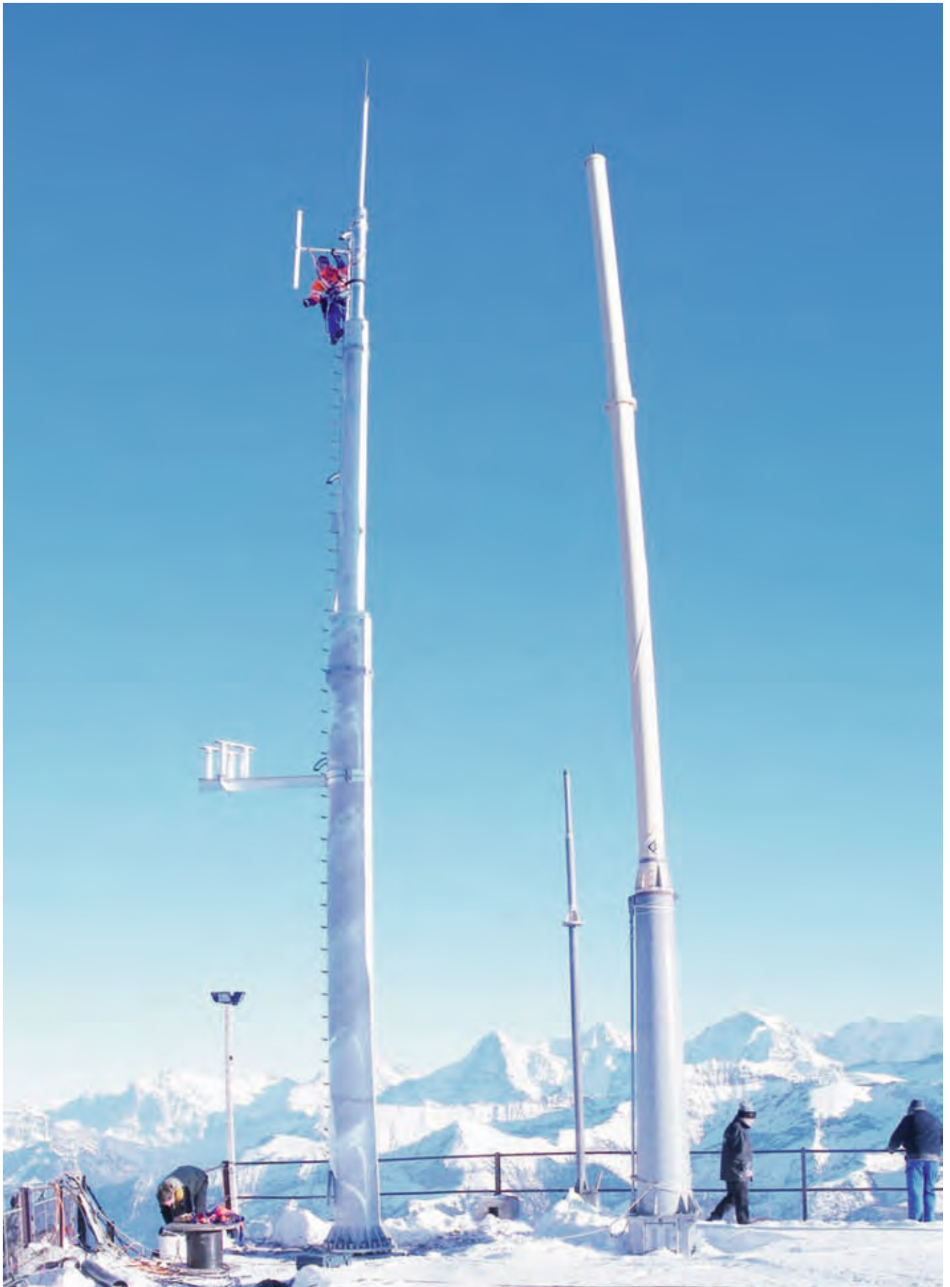
Links: Der neue Mast von Radio BeO mit montierter Notantenne, rechts der Mast des Militärs
